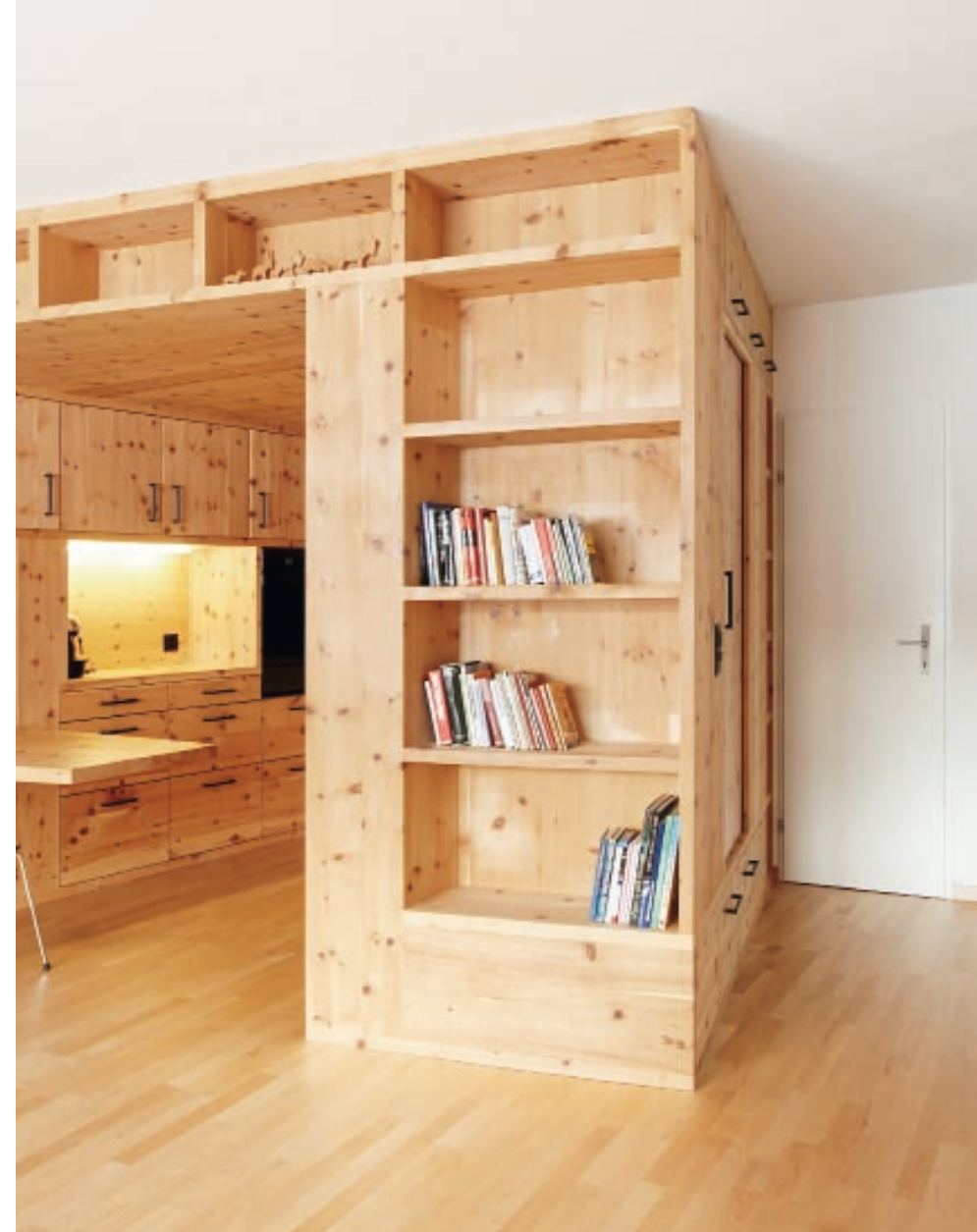
Massiv: Selbst Schränke und deren Innenleben wurden aus massiven Brettern gezimmert.
