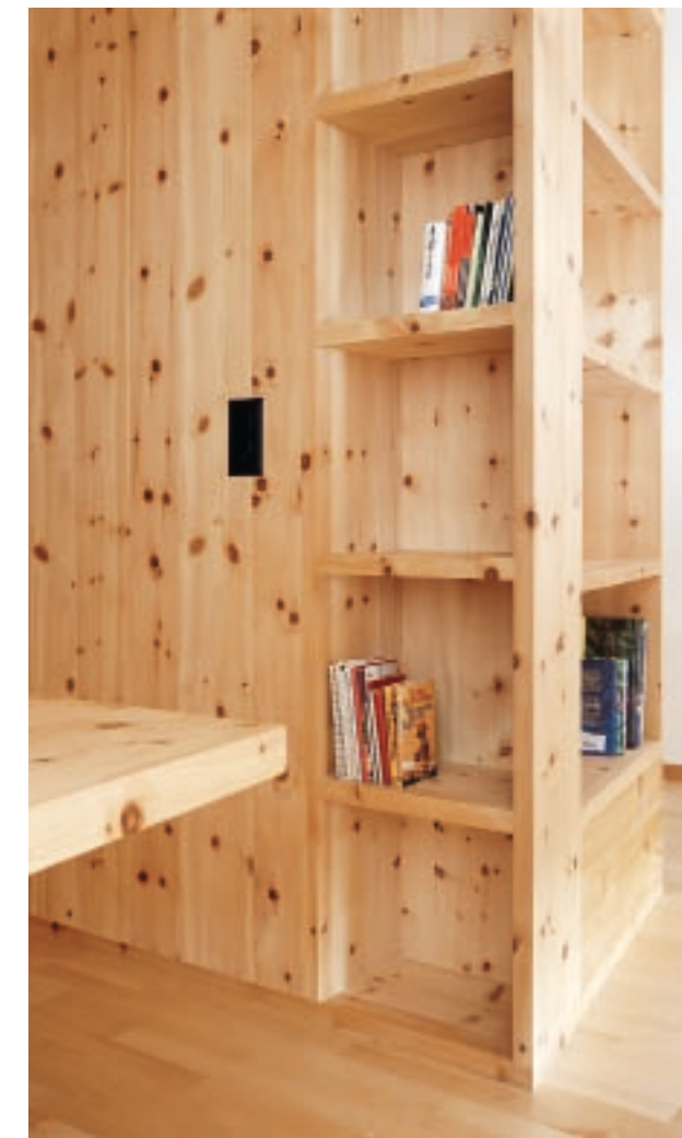
Massiv: Selbst Schränke und deren Innenleben wurden aus massiven Brettern gezimmert.
