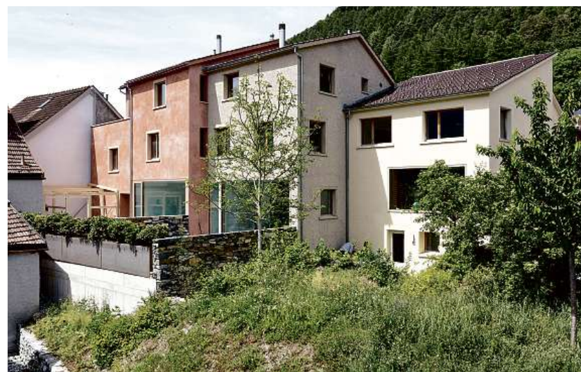
... die Wohnhäuser Im Winggel in Haldenstein ...
