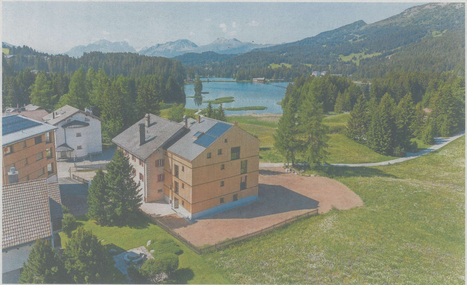
Im neuen Kleid: Das bisherige Lagerhaus Canols in Valbella ist saniert und zum Camp Lai erweitert worden.
