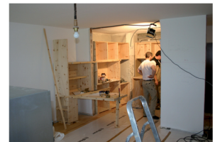
MONTAGE VOR ORT
