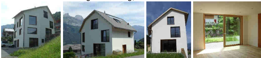
Neubau EFH mit Einliegerwohnung, Quarten
