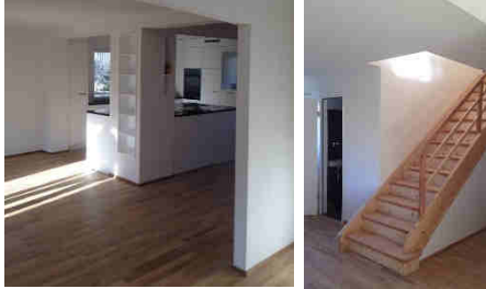
Umbau Wohnhaus , Chur
