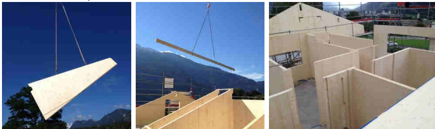
Neubau EFH, Chur
