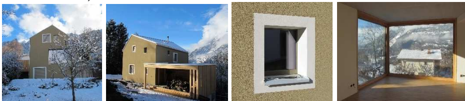
Neubau EFH, Chur
