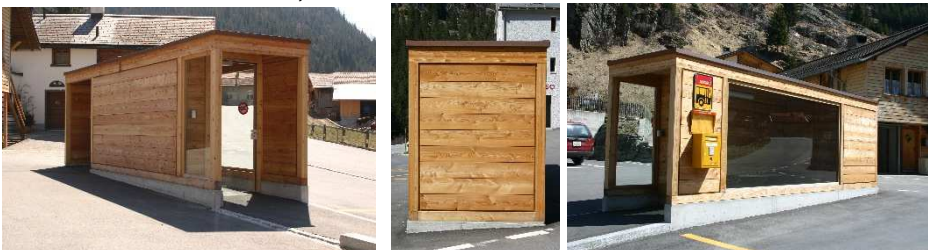
Neubau Bushaltestelle, Ausserferrera
