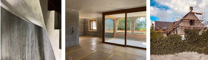
Neubau MFH, Malans
