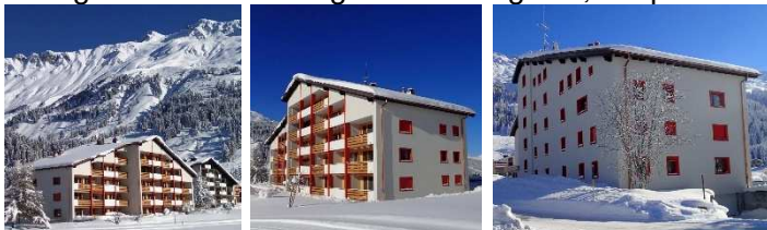
Energetische Sanierung MFH Triangel-A, Parpan
