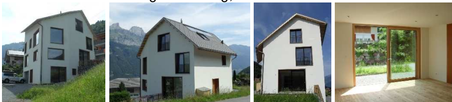
Neubau EFH mit Einliegerwohnung, Quarten
