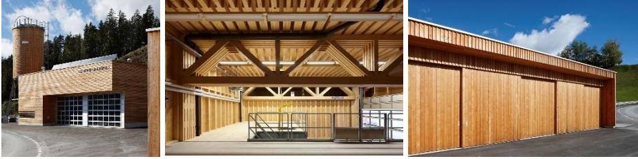
Neubau Stützpunkt Kanton GR, Tiefbauamt, St. Peter/Pagig
