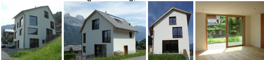
Neubau EFH mit Einliegerwohnung, Quarten
